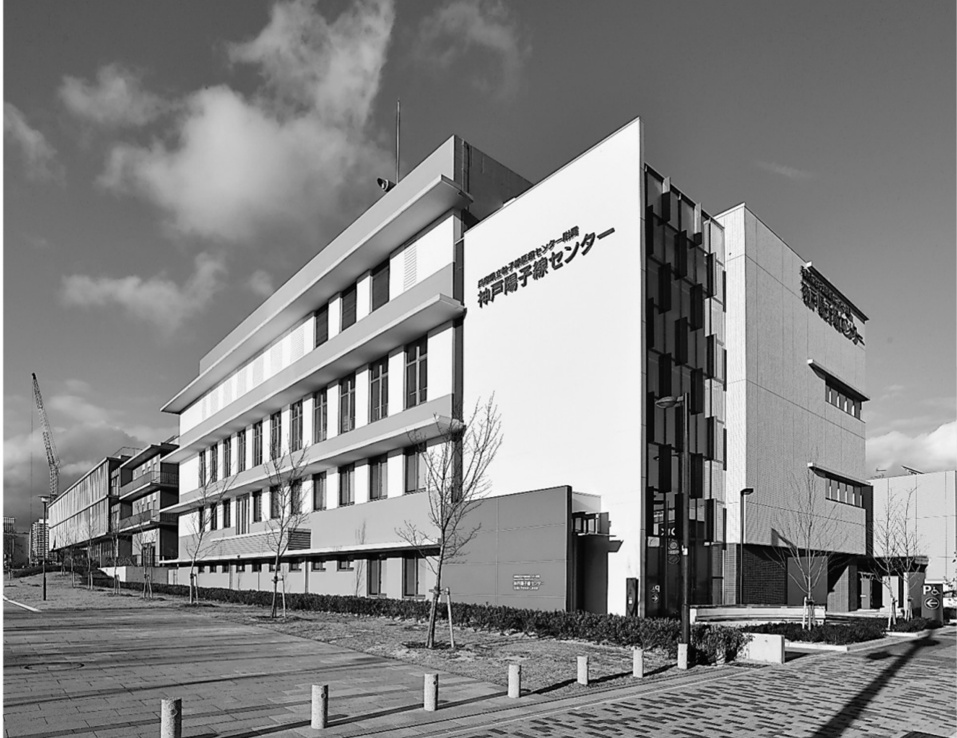
昨年12月にオープンした神戸陽子線センター。左奥は県立こども病院。連携体制が整っている神戸陽子線センター
